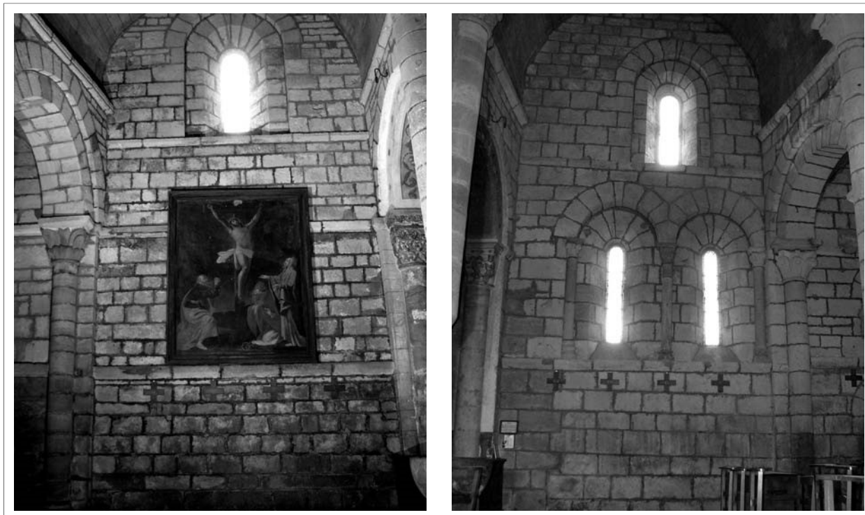
FIG. 22. BRAS NORD ET SUD DU TRANSEPT, élévations intérieures. Cl. A. Charrier.
