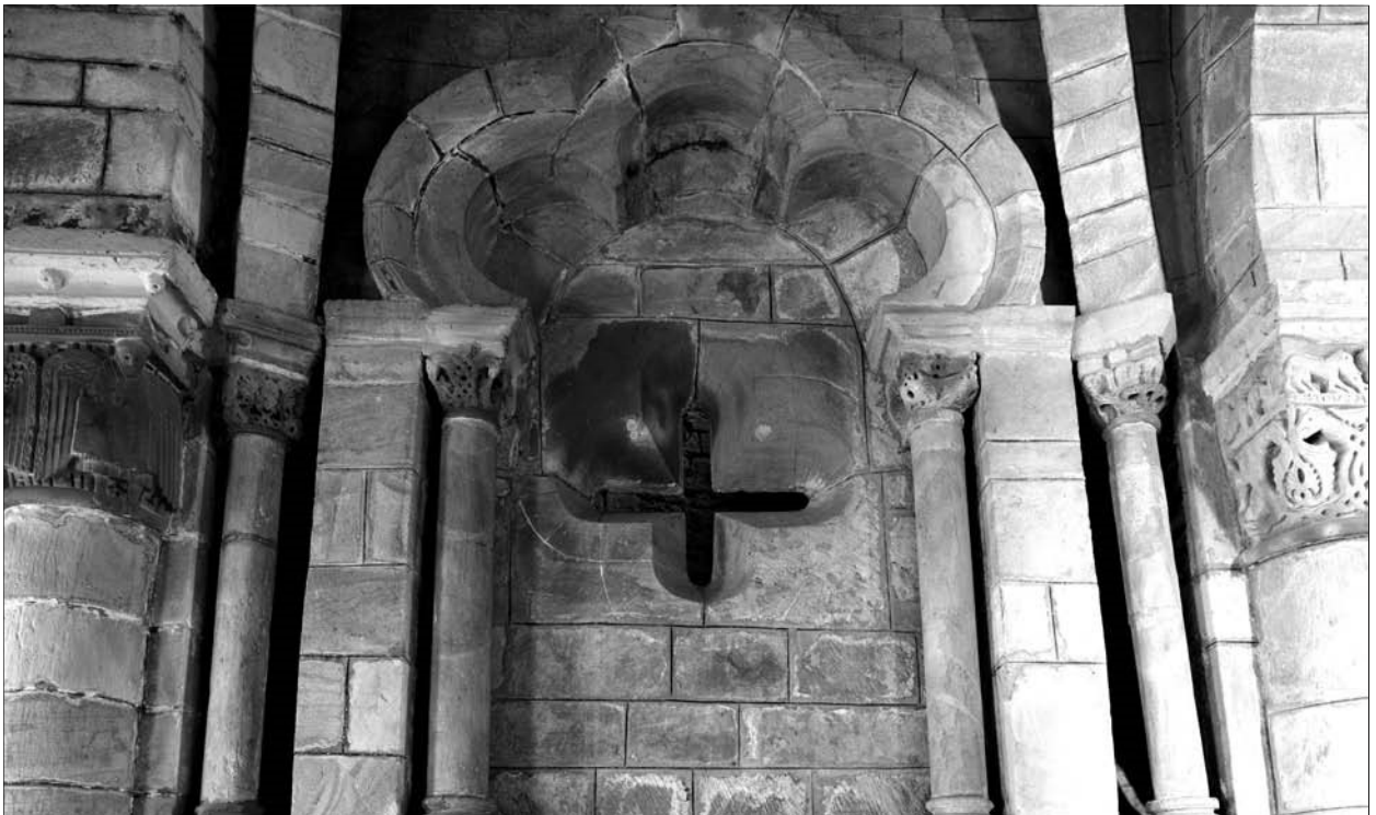
FIG. 14. TRAVÉE DROITE DU CHŒUR, détail de la fenêtre cruciforme sud. Cl. N. Blaya.
