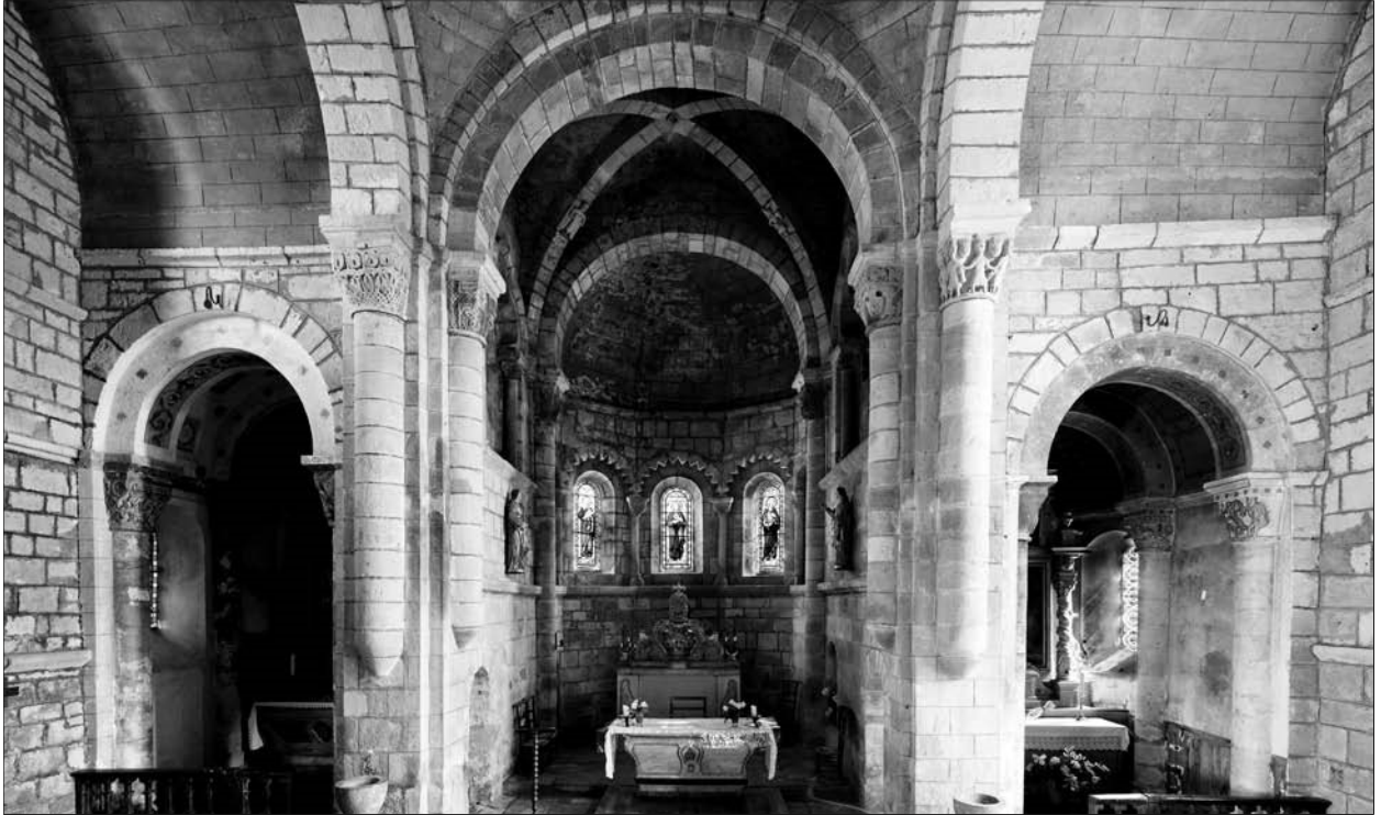
FIG. 13. ÉGLISE DE SAINT-PIERRE-TOIRAC, vue générale du chœur. Cl. N. Blaya.
