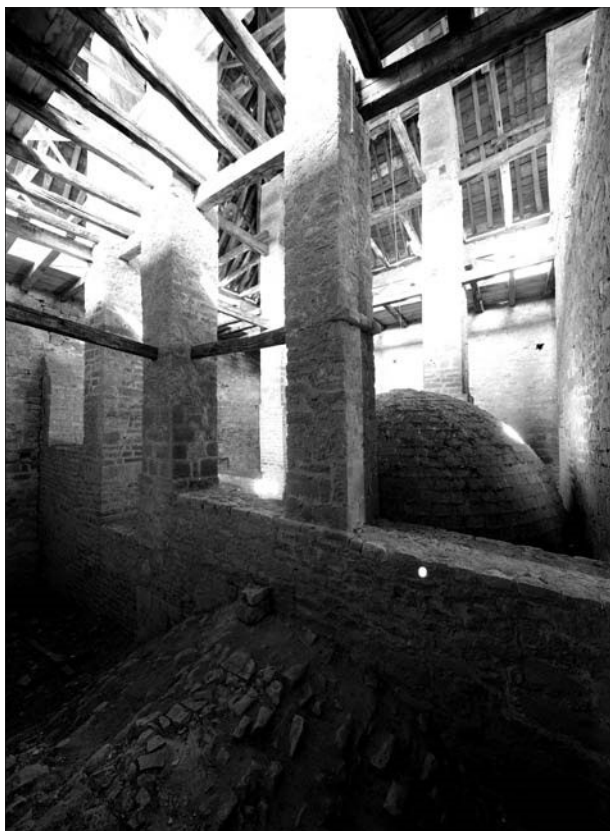
FIG. 26. COMBLES, vue générale depuis le sud-est. Cl. N. Blaya.
