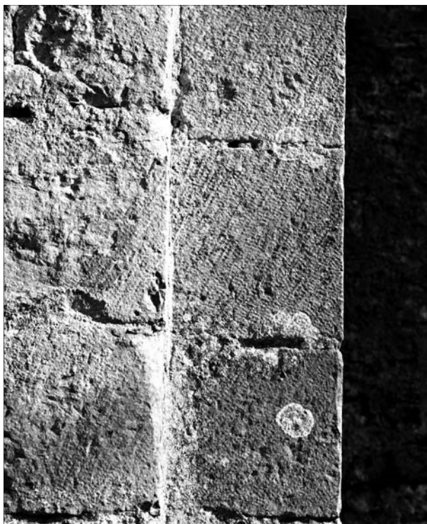
FIG. 9. ANGLE NORD-OUEST, détail des traces de taillant brettelé témoignant des réparations apportées à l'ensemble de l'angle de l'édifice dans le courant du XIII e siècle. Cl. A. Charrier.
